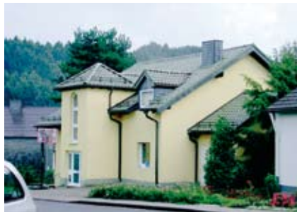
Wohnhaus nach Dachsanierung mit glasierten Tondachziegeln und Schneefanggittern
