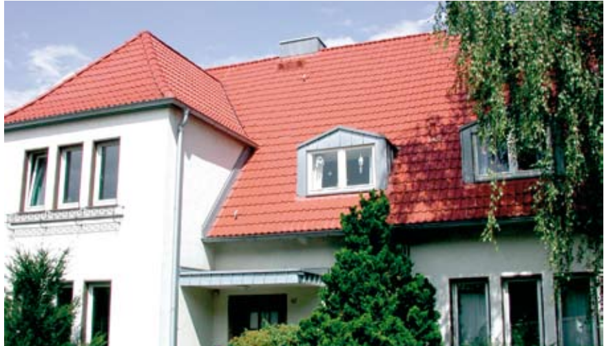
Wohnhaus nach Dachsanierung mit Betondachsteinen und Stehfalzverkleidung
