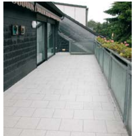
Fläche und kritische Detailpunkte wie Tür- und Wandanschluss sowie Geländerstützen sind dauerhaft sicher abgedichtet. Die Fläche erhielt auf Wunsch des Bauherren eine individuelle Gestaltung in Fliesenoptik.
