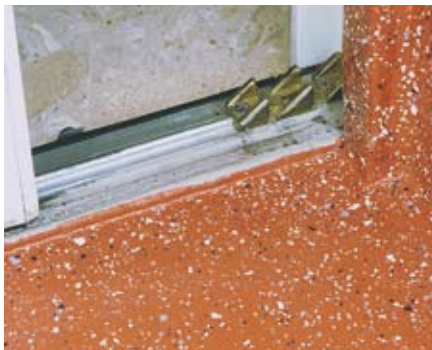
Sichere Abdichtungen vom Fachmann: z.B. an einer Schiebetür oder am Gully mit nur 1 cm Anschlusshöhe
